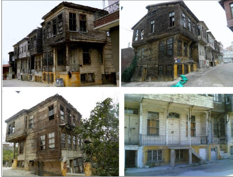
Şekil 7. Konutların restorasyon öncesindeki durumları, Cemal Nadir Sokak, Saadet Sokak (Tekirdağ Büyükşehir Belediyesi Arşivi, 2016)
