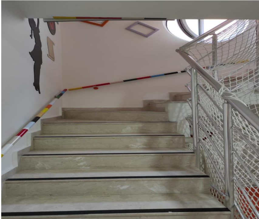
Resim3: Kütüphane Binasında Bulunan Merdivenler
