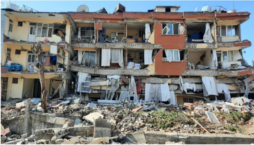
Şekil 6. Hatay kent merkezi ağır hasar gören ve yıkılan yapılar (TMMOB s.24).
