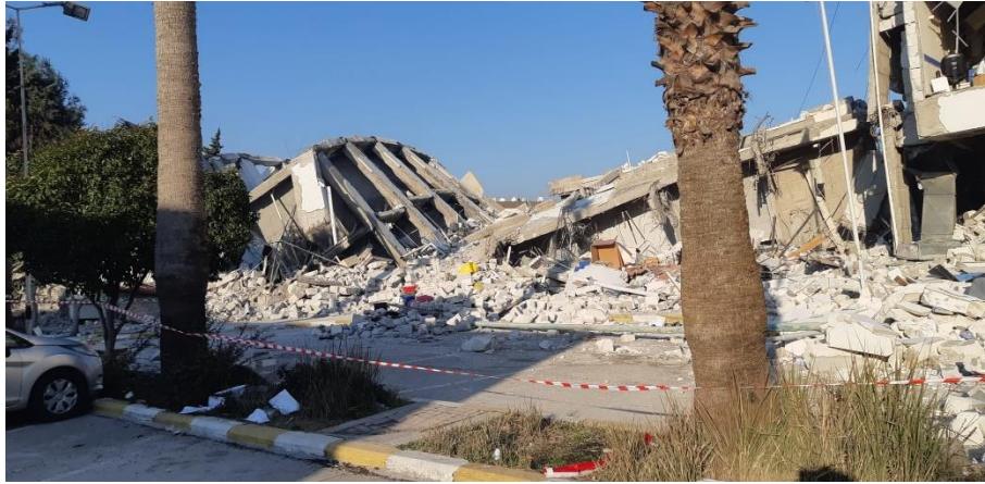
Şekil 18. Hatay'da Deprem Sonrası Yıkılan Binaların Olduğu Bir Bölge
