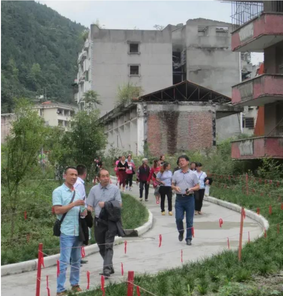
Şekil 10. Beichuan 'da Müzeye Dönüştürülen Deprem Kalıntıları (Brook, 2017).
