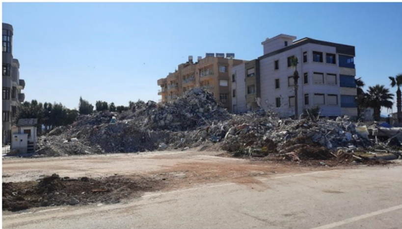
Şekil 13. İskenderun sahil şeridindeki yıkılan yapılar (TMMOB s.30).
