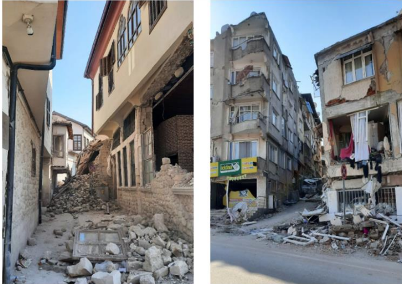
Şekil 9. Hatay kent merkezi 6 Şubat 2023 depremleri sonrası hasar (TMMOB s.27).
