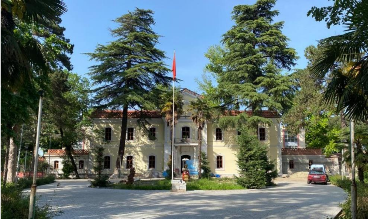
Şekil 15 Bursa Hüdavendigâr Ziraat Mektebi İdari Binası (Kişisel Arşiv, 2023)
