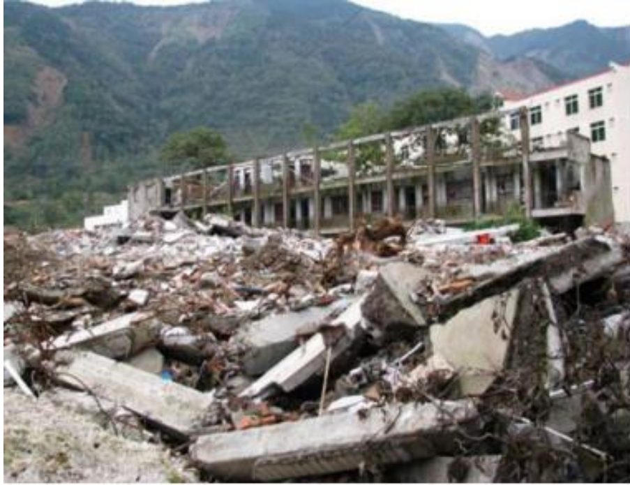
Şekil 6. Beichuan Depreminden Görünüm (Huang vd. 2012: s.1003).
