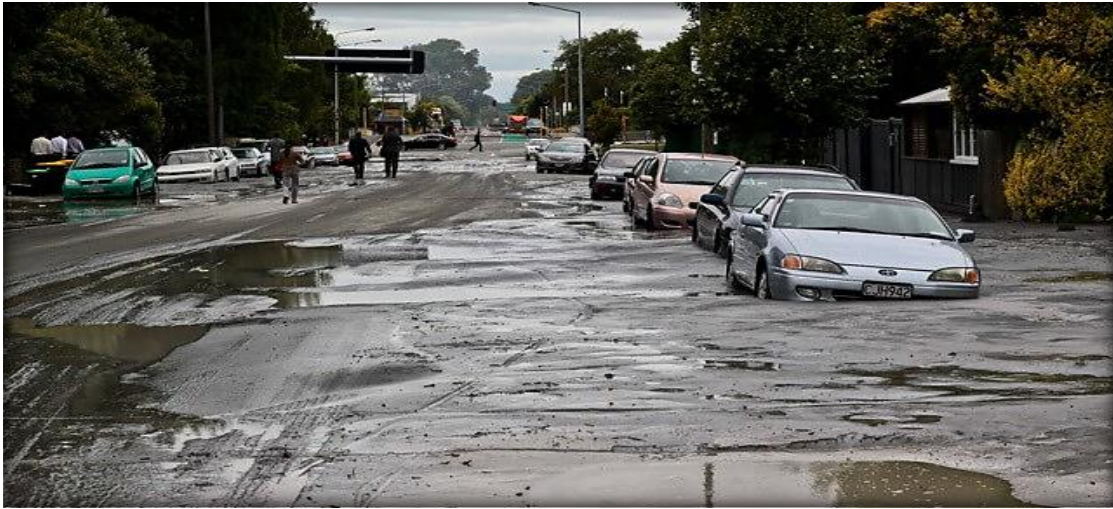
Şekil 3. Zemin Sıvılaşması
