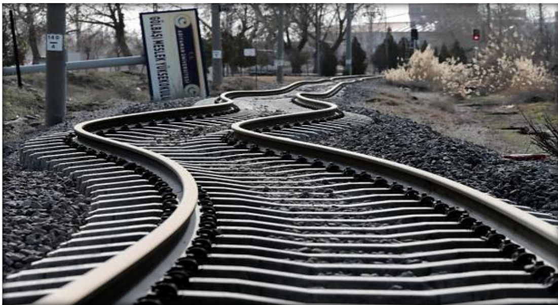
Şekil 9. Depremin Demir Yolu Üzerindeki Etkisi (Kaynak: SBB,2023)
