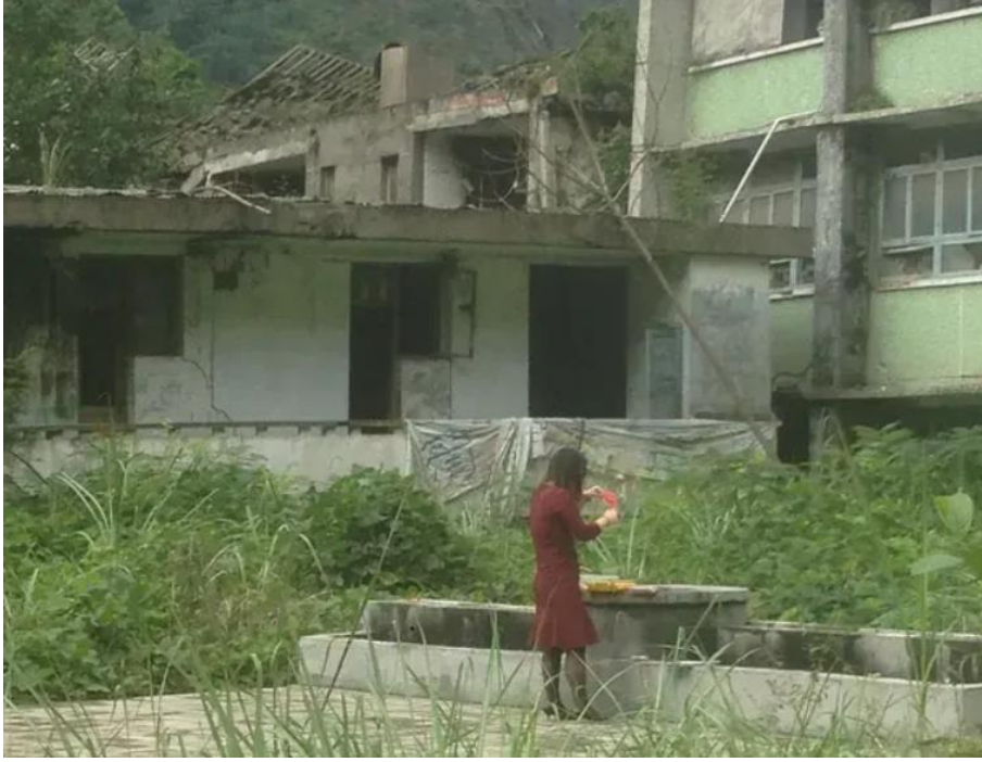
Şekil 9. Beichuan 'da Müzeye Dönüştürülen Deprem Kalıntıları (Brook, 2017).
