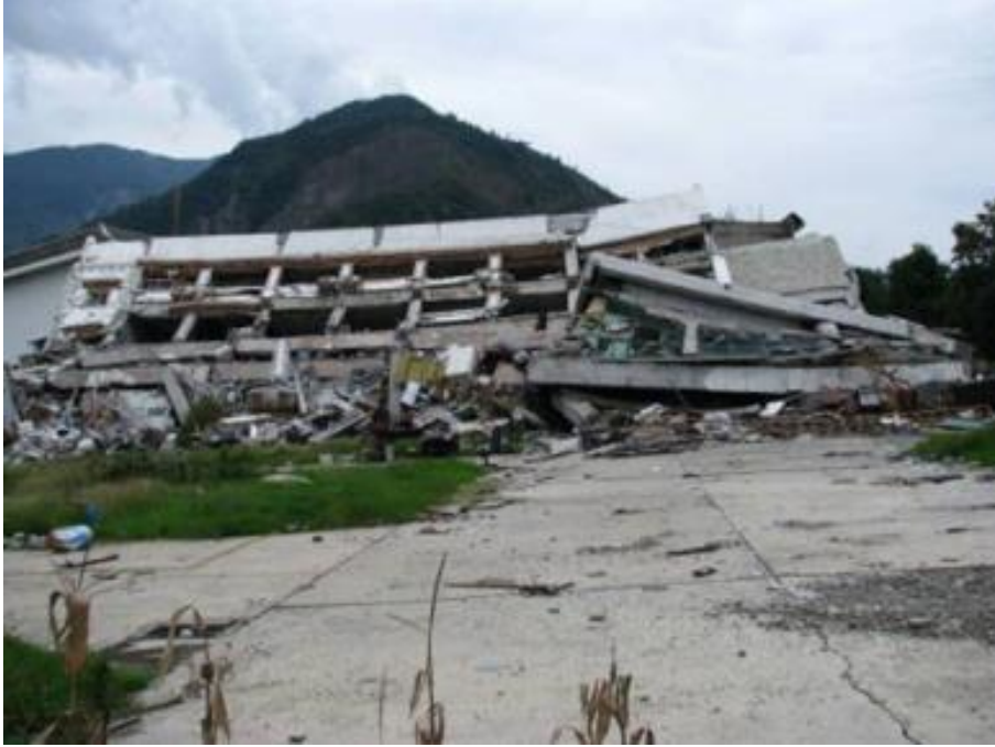
Şekil 8. Beichuan Depreminden Görünüm (Huang vd. 2012: s.1003).
