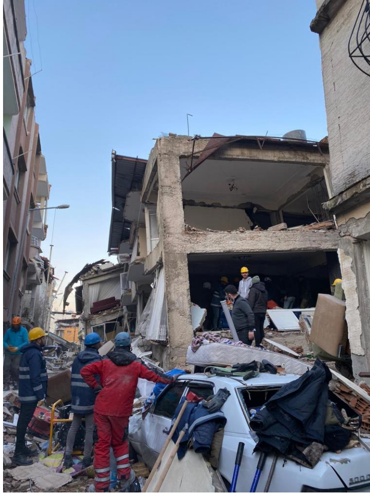
Şekil 17. Hatay'da Deprem Sonrası Yıkılan Binaların Olduğu Bir Bölge
