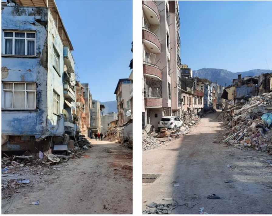
Şekil 10. Hatay kent merkezi 6 Şubat 2023 depremleri sonrası hasar (TMMOB s.28).
