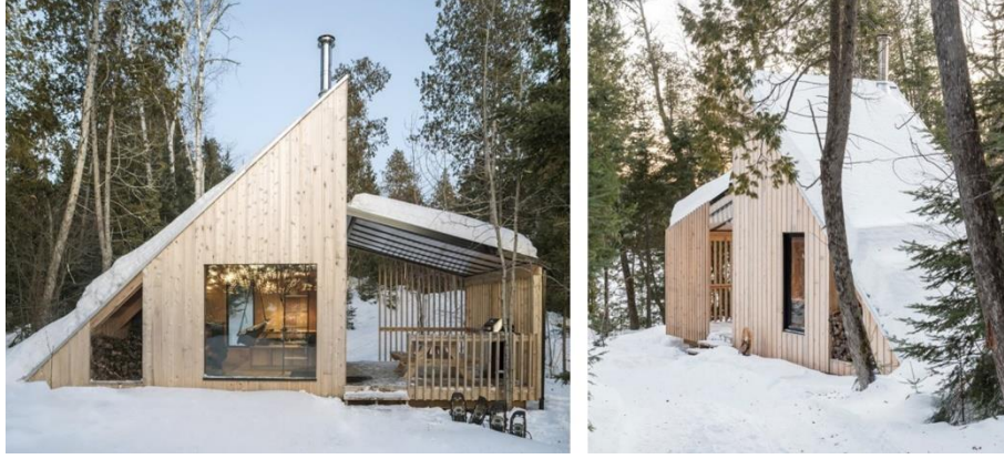
Şekil 13. La Pointe yapısının dış cephe görünüşü
