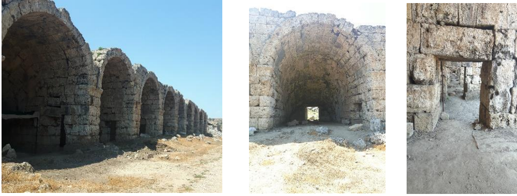
Şekil 1. Perge Stadyumu Dükkanlar – Eğik Tonoz ve Ara Geçişleri
